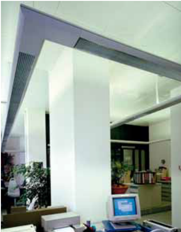
Blendfreie Bürobeleuchtung mit Parabolraster P 13
